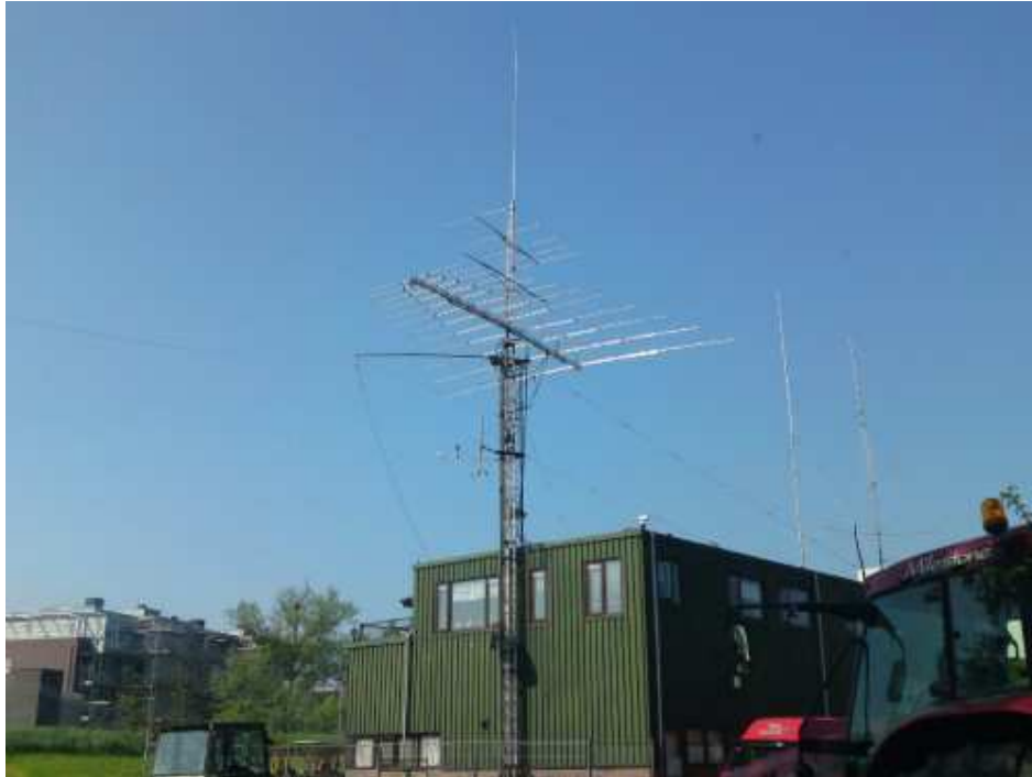
Vrijstaande antenne-installatie op bedrijventerrein
